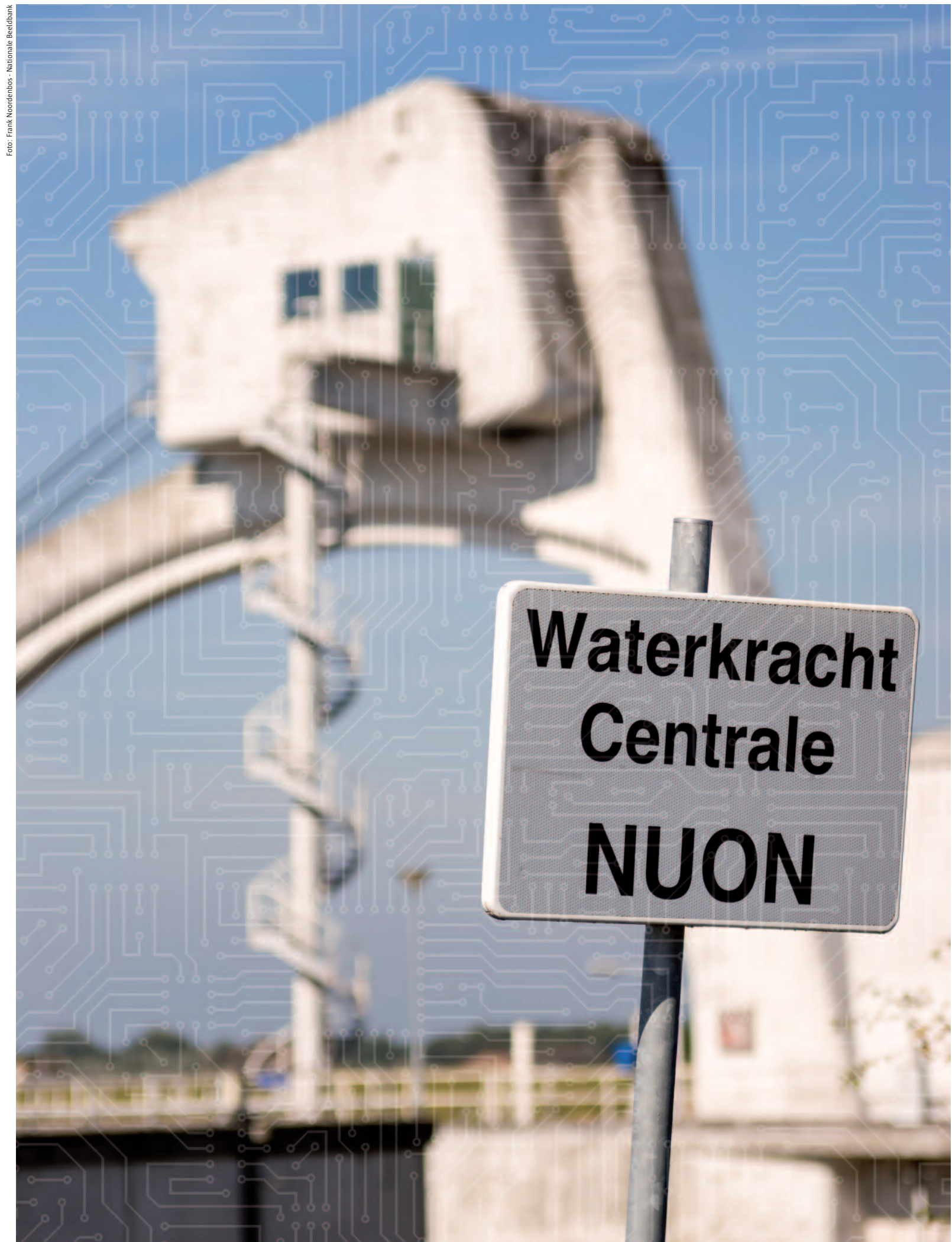
Maatwerk en gerichte acties zijn nodig voor de bescherming van de vitale infrastructuur, maar óók voor andere delen van onze economie. Bedrijven in de topsectoren, cruciaal voor het verdienvermogen van onze economie, blijken bijvoorbeeld zeer kwetsbaar te zijn voor digitale spionage.
