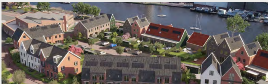
Impressie van een van de nieuwbouwlocaties aan het Noordeinde in Wormerveer
